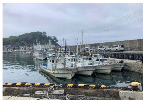
輪島港漁船だまり②現況 (4月30日)
