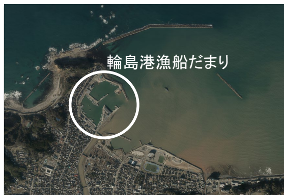
輪島港全体写真
