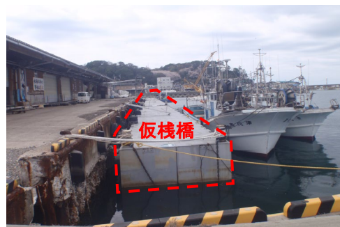
輪島港漁船だまり①仮棧橋設置状況 (4月23日)
