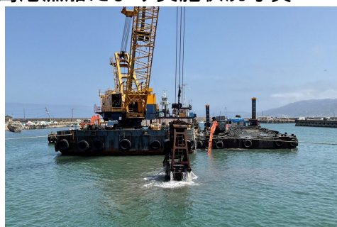
輪島港漁船だまり③浚渫状況 (4月22日)
