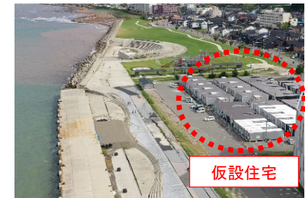
マリンタウン仮設住宅立地状況
