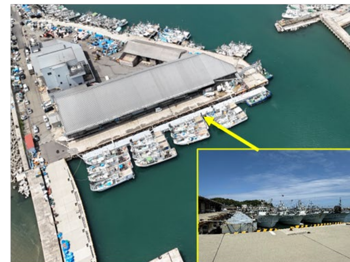
物揚場の高さに高さ合わせた応急対策 (仮棧橋設置)
