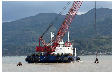
起重機船（弘武）による緊急浚渫状況
