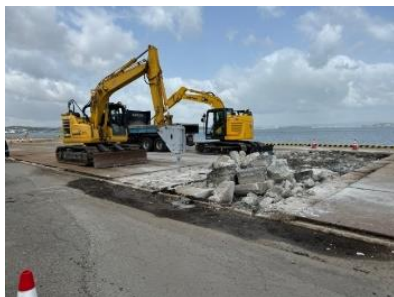
復旧工事の状況(コンクリート舗装撤去)
