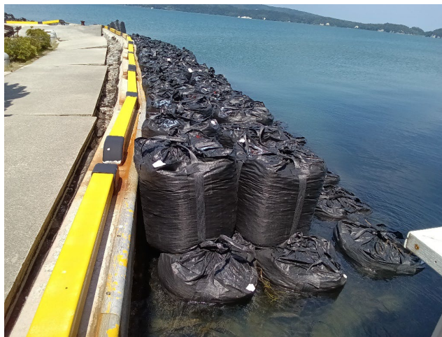
応急復旧工事 完了
