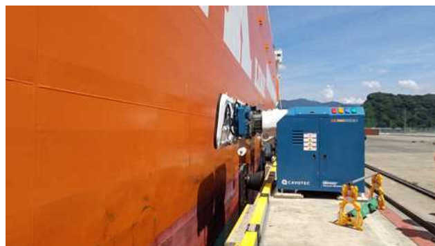
自動係留装置吸着の近景
