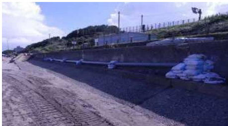
排水対策としての塩ビ管の設置
