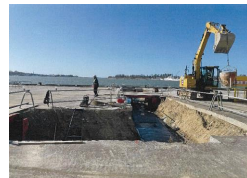
圧送用配管復旧工事
