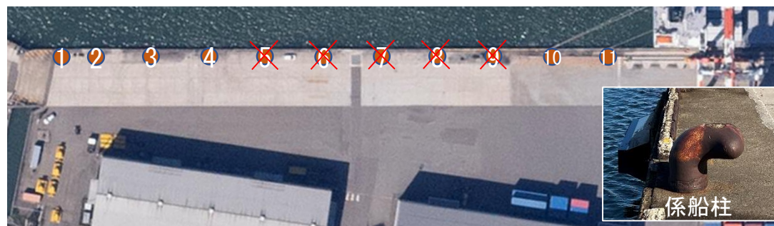
11基の係船柱のうち5基が使用不可
