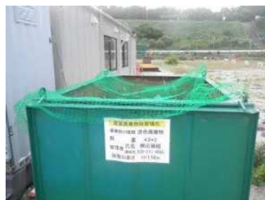
産廃BOXの飛散防止対策のネットの設置
