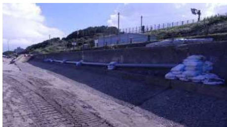
排水対策としての塩ビ管の設置
