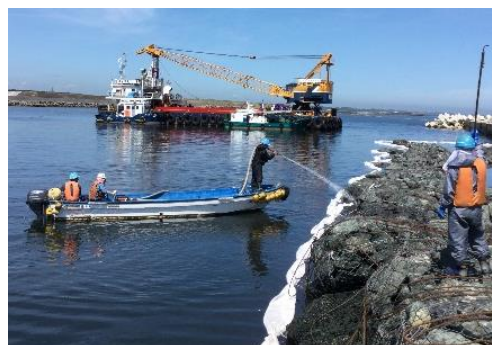
▲埋浚 護岸に付着した油の回収作業
