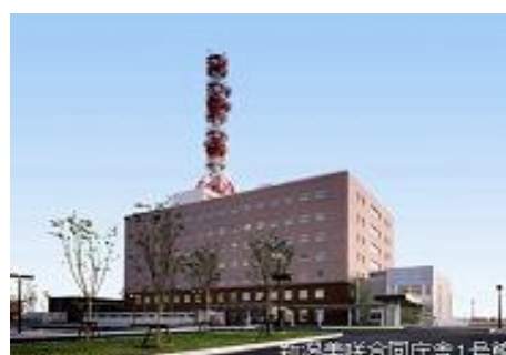
新潟美咲合同庁舎 1 号館
