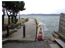
護岸の傾斜(被災後)
