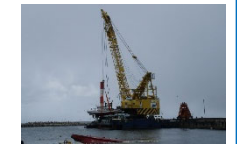
航路啓開の状況(2/27)
