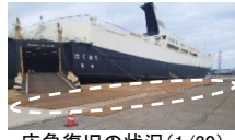
応急復旧の状況(1/30)
