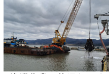
浚渫作業の状況(2/16)
