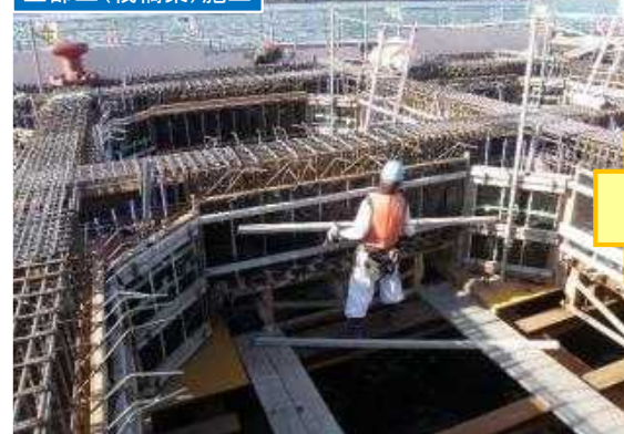
上部工(栈橋梁)施工
