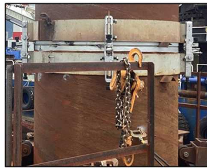
「建て方エース」実施状況
