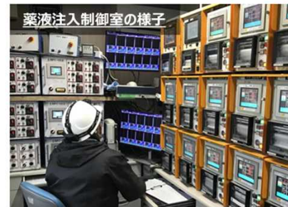
薬液注入制御室の様子
