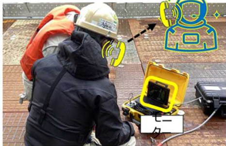
鋼管杭打設中の水中カメラによる確認状況
