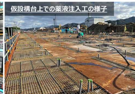
仮設構台上での薬液注入工の様子
