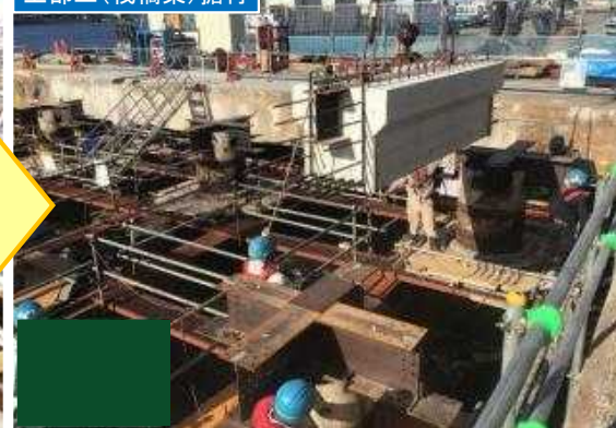
上部工(栈橋梁)据付
