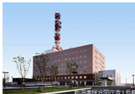
新潟美咲合同庁舎 1 号館
