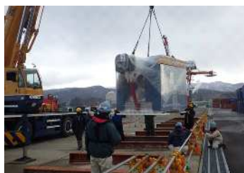
装置敦賀港到着状況
