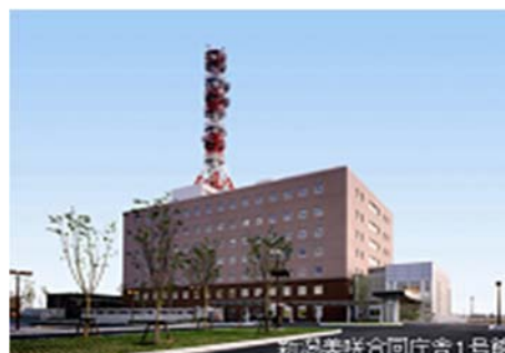
新潟美咲合同庁舎１号館
