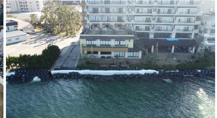
大型土のう設置(応急復旧)
