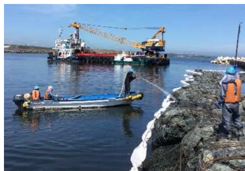
▲埋浚 護岸に付着した油の回収作業
