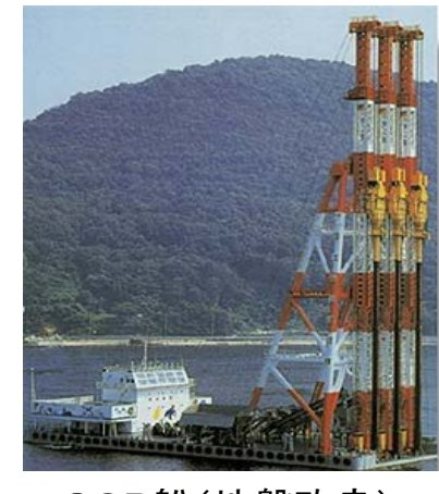
SCP船(地盤改良)
