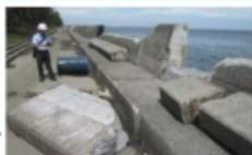
高波による護岸倒壊事例(令和元年房総半島台風)【横浜港】
