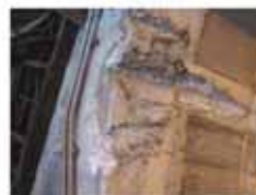
大型車による覆工の擦り状況
