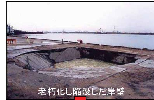
老朽化し陥没した岸壁
