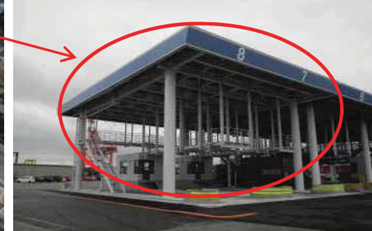
H25年度 トレーラゲート 2レーン増設完了
