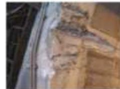
大型車による覆工の擦り状況
