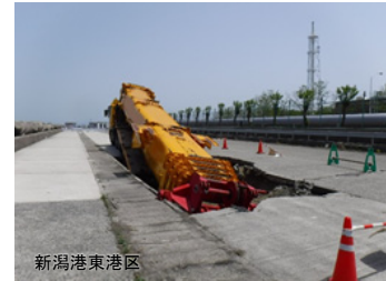
■臨港道路の陥没(H30.5 発生)
