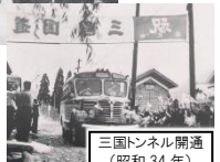
三國トンネル開通(昭和34年)
