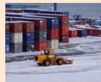
コンテナヤードの除雪 作業（新潟港）
