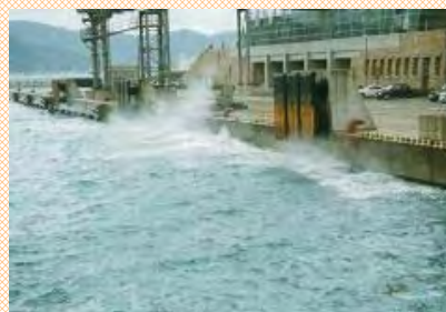
静穏度が不足する港内 （敦賀港）
