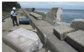
高波による護岸倒壊事例(令和元年房総半島台風) [横浜港]
