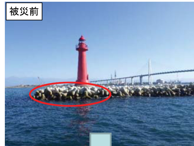
事例2 伏木富山港防波堤 令和元年東日本台風(台風19号)
