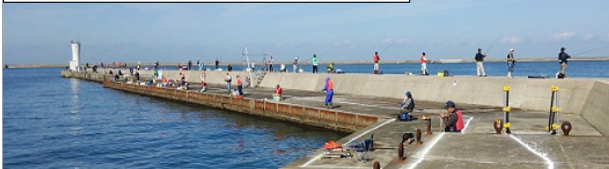
防波堤の一部を釣り場として開放(写真は直江津港)
