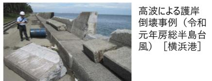
高波による護岸倒壊事例(令和元年房総半島台風) [横浜港]
