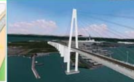
自転車歩行者道を備える新湊大橋
