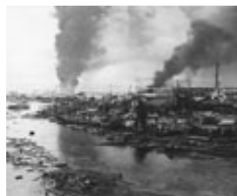
写真-2 新潟地震により発生した石油タンク火災
