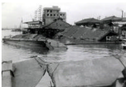
写真-1 新潟地震による津波で転覆した漁船と水没した建物
