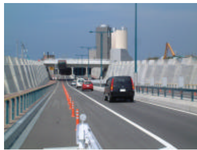
新潟港（西港地区）新潟みなとトンネル
