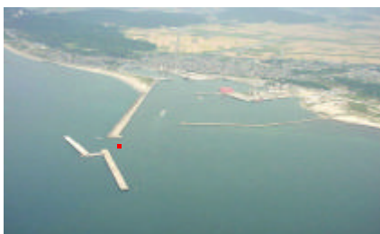
写真-11 防波堤による港湾の静穏性の確保（岩船港）
