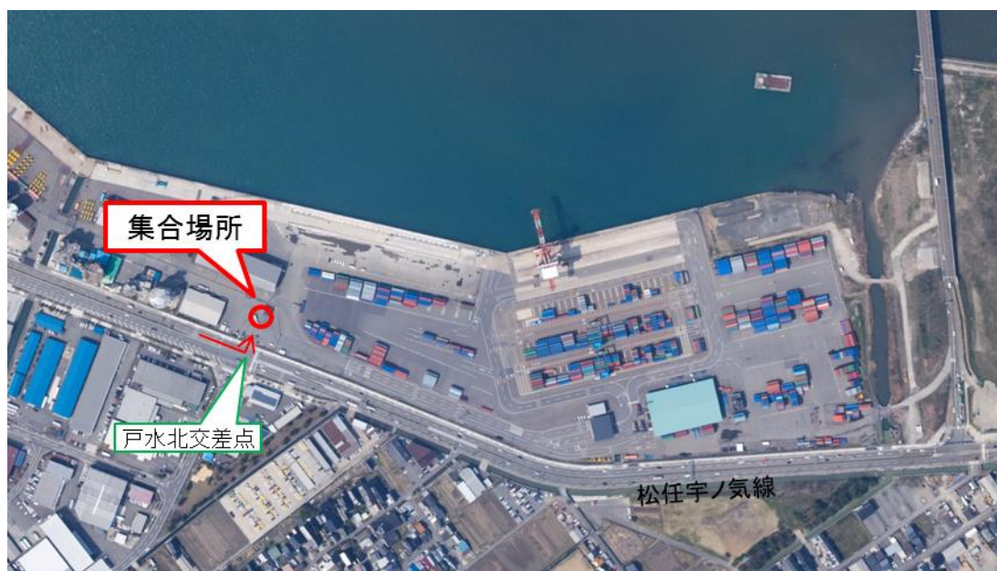
金沢港（南地区）コンテナヤード
