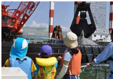
浚渫工事(グラブ浚渫船)を間近に
