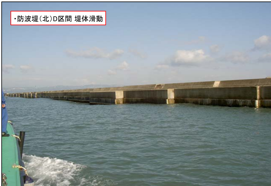
・防波堤(北)D、D'区間 堤体滑動
