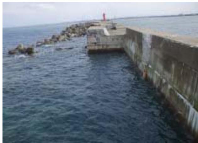
(a) 消波ブロックの飛散・衝突による上部工欠損 (b) B 区から A 区（堤頭部）を望む
