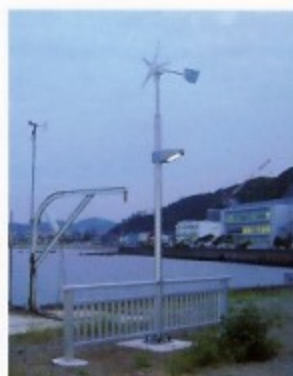
沿岸風力照明支柱
