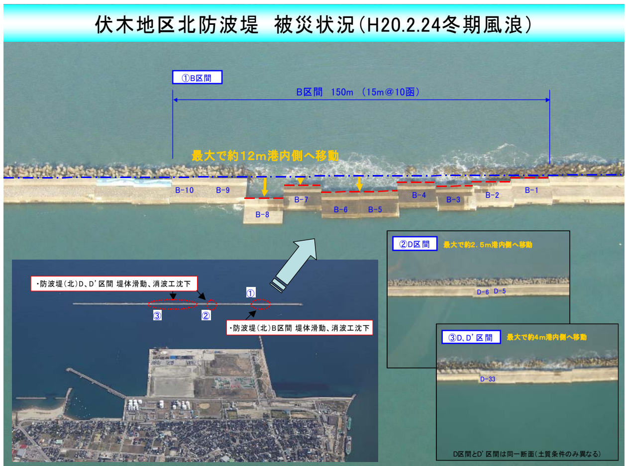
図 1.1.5 北防波堤の被災状況
