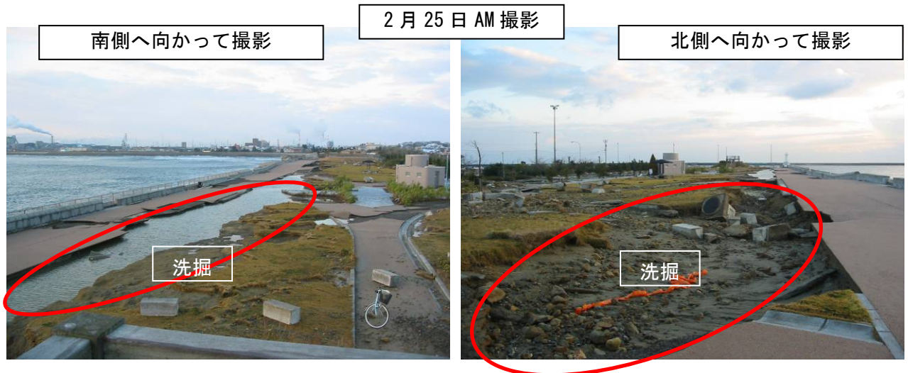
図 4.2.4 万葉埠頭緑地の被災状況
