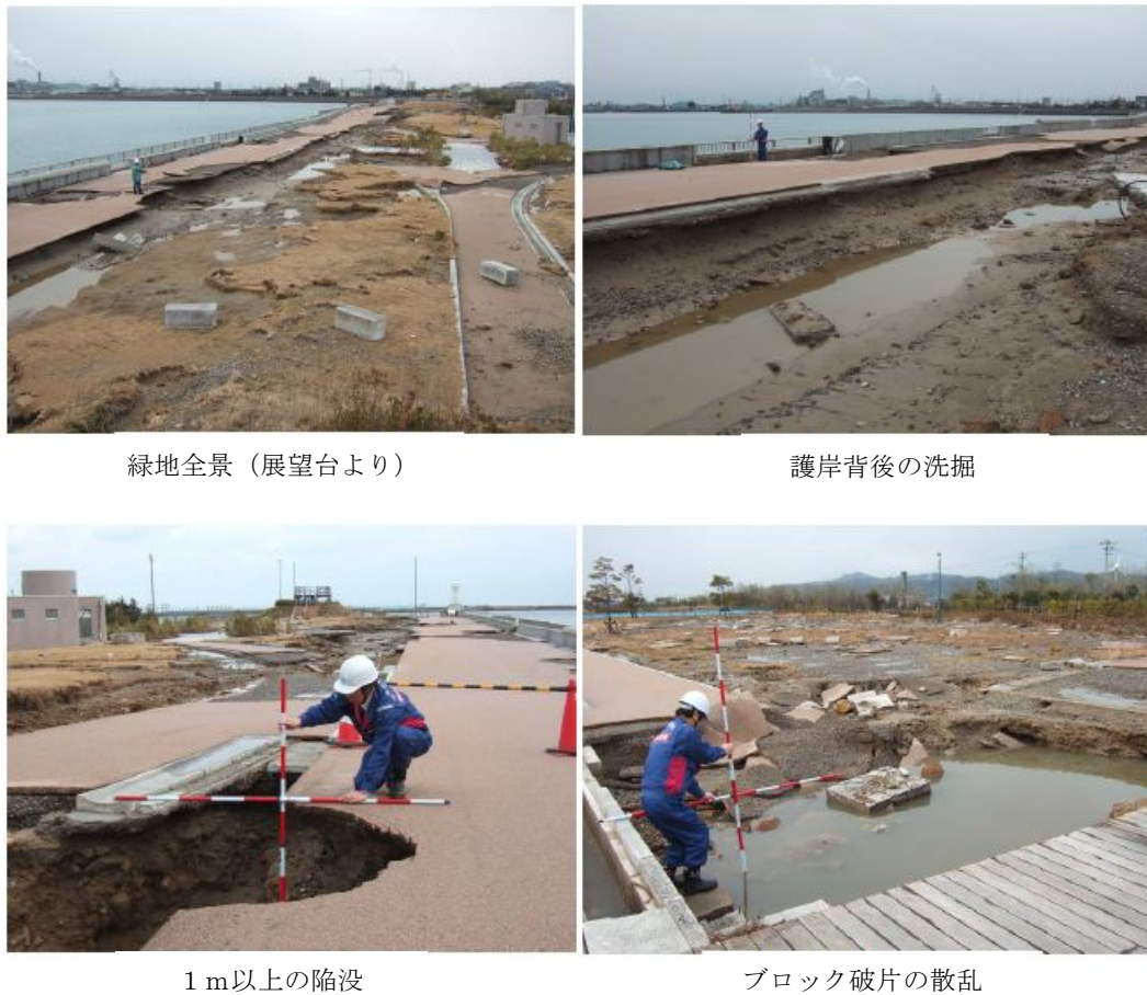
図 1.1.7 万葉埠頭緑地の被災状況
