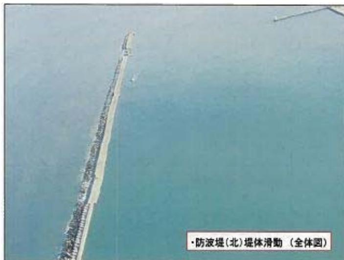
図 2-2 北防波堤の被災状況（全体図）
