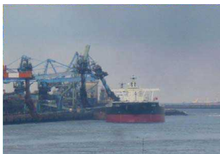
地震で被災した鹿島港 (飼料の原料となる穀物を荷揚げする岸壁やアンローダー等が被災)
