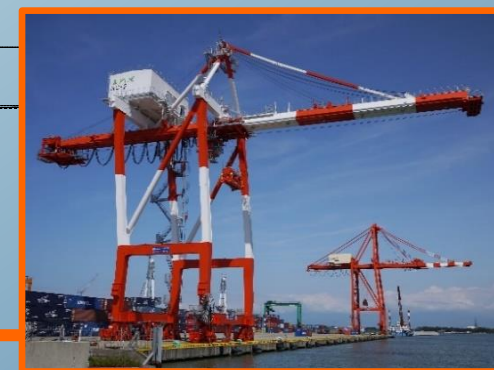
ガントリークレーン 2基 (うち1基を更新し、R5.9供用開始)
